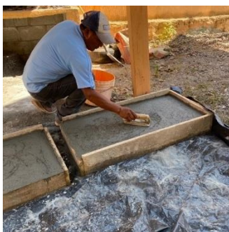
Elaboración de planchas de concreto para arreglo de rampa entrada al municipio.
