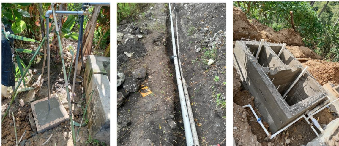
Reposición Sistema De Agua Potable Aldea Los Encuentros, San Juan Ermita, Chiquimula Costo: Q. 1,249,017.99
