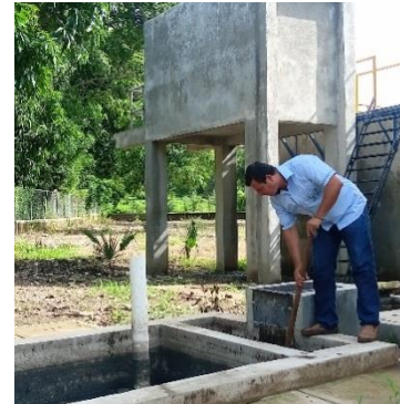
Limpieza de los desarenadores que acumulan residuos.
