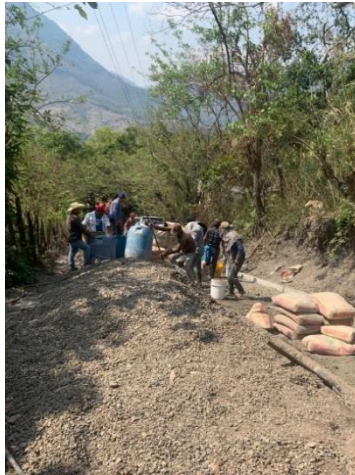
Inicio del proyecto mejoramiento del camino rural, Aldea Caulotes.
