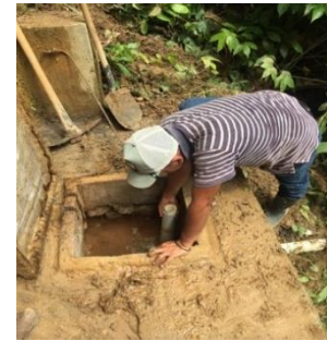
Revisión de caja de captación del sistema el barrancón.
