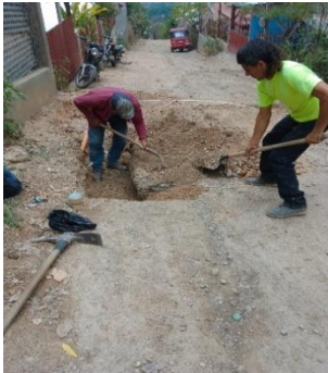
Instalación de servicio de agua potable.
