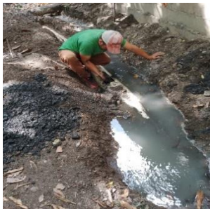
Arreglo de drenaje en el barrio el Campo.
