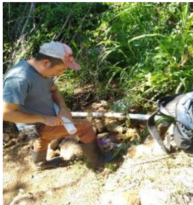
Arreglo de tubería en la línea de las ventanas
