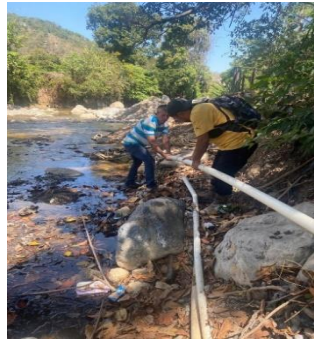
Arreglo de tubería de la línea de conducción del sistema de las ventanas.
