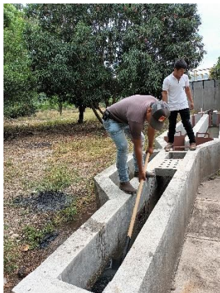
Limpieza de las rejillas que acumulan desechos y residuos que van del tanque de visita.
