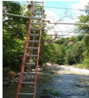
Arreglo de tubo aéreo línea de las ventanas
