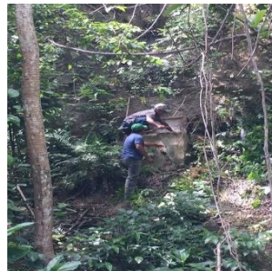
Revisión de la caja de captación del sistema de las ventanas.
