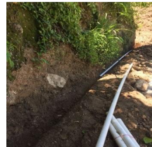
Arreglo de servicio de agua en el barrio la Escuela.
