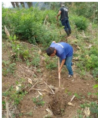
Arreglo de la tubería del sistema de agua sector los Garcías.
