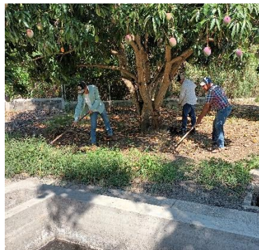
Limpieza (recolección) de basura en las diferentes instalaciones de la planta de tratamiento de aguas residuales.
