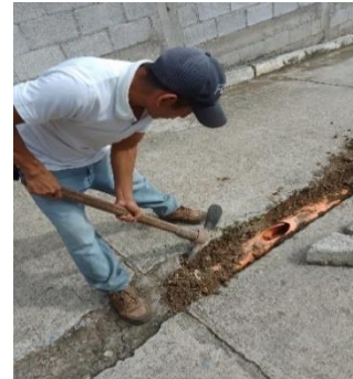
Arreglo de drenaje en el barrio la tejera.
