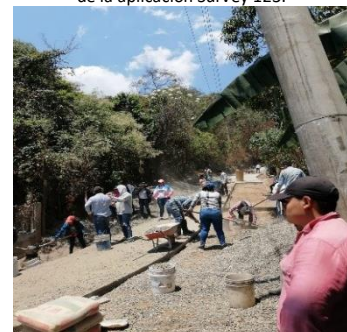
Apoyo en la construcción de fraguado en la Aldea Caulotes.
