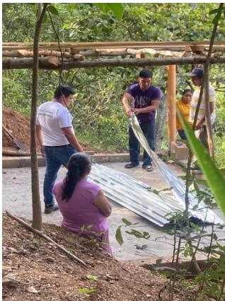
Apoyo a ASEDECHI en la construcción de galpón para pollos en Aldea Buena Vista.
