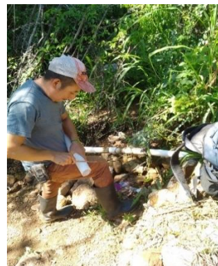
Arreglo de tubería en la línea de las ventanas.
