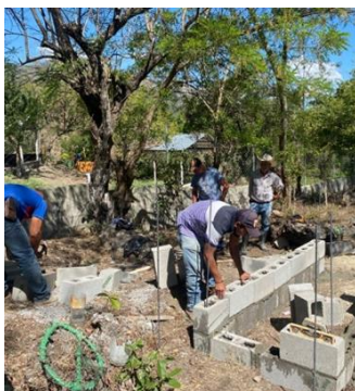
Construcción de bóveda Aldea Los Planes.
