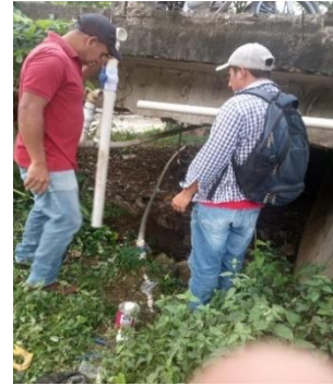
Reparación de desperfecto de tubería del barrio la Escuela.
